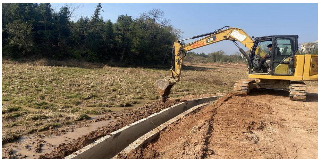
图 3-24 道县七里岗村开展水渠施工建设
